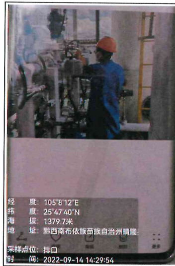
部分采样照片
